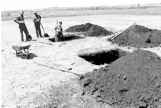
Figura 1. Área experimental com o local de instalação dos lisímetros.
